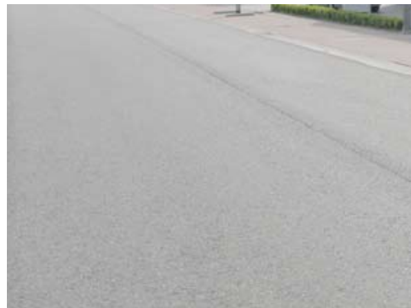
De rijweg wordt uitgevoerd in lichtgrijs asfalt waarbij in de belijning door middel van zwartkleurige 'streetprints' de rijbaan visueel wordt versmald
