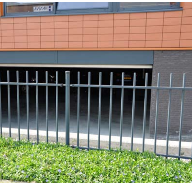
Parkeren en logistiek geïntegreerd in het gebouw
