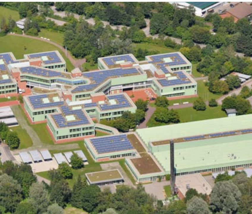
Groene gevels, groene daken en zonne-energie
