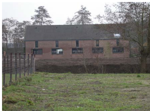
Bedrijfsgebouw in de stijl van een agrarische schuur
